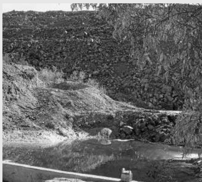
Presa minera de La Aguzadera que en 2007 filtraba aguas ácidas al río Odiel.
