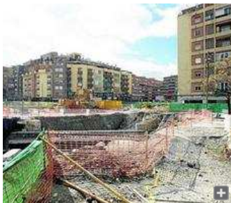
Estado de las obras en la Plaza Einstein de la capital.
