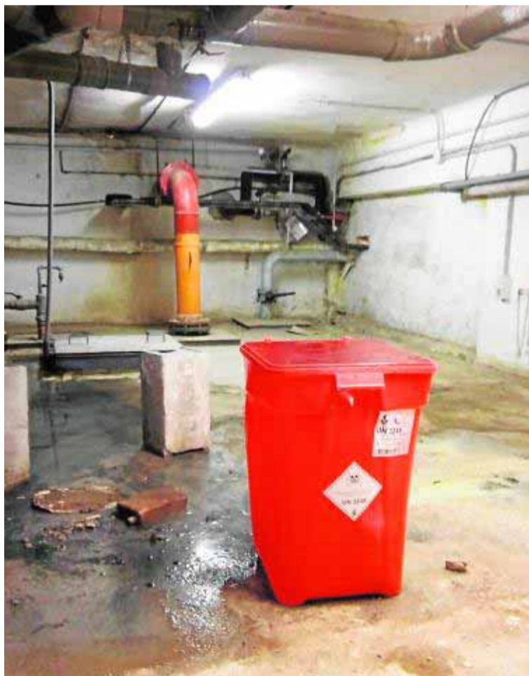
Contenedor lleno de goteras el Clínico, bajo las cocinas. :: IDEAL
