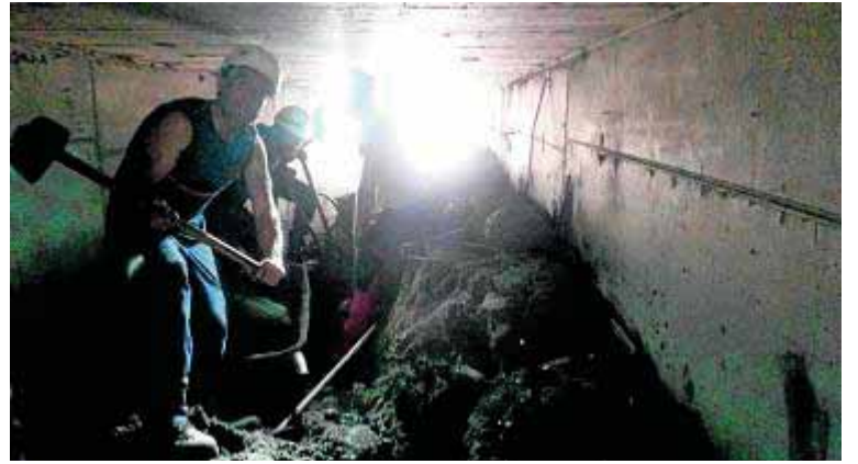
Tubería desde donde fueron arrastrados por el agua tres víctimas. :: J. M.
