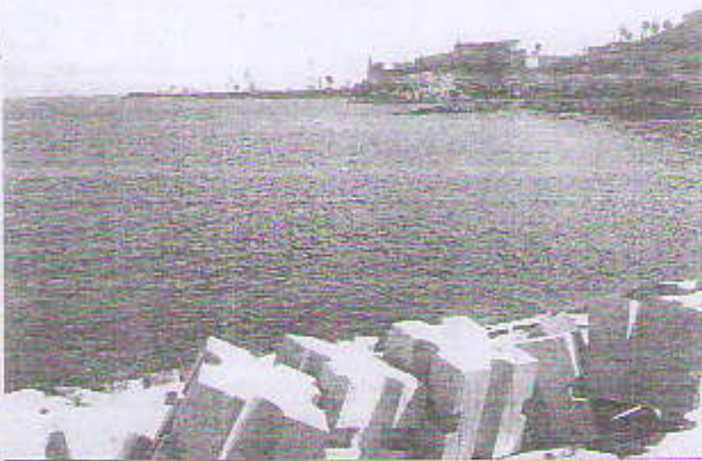
La zona de Hornos Colorados y el espigón del puerto son donde mayor concentración de Patella Ferruginea hay.
