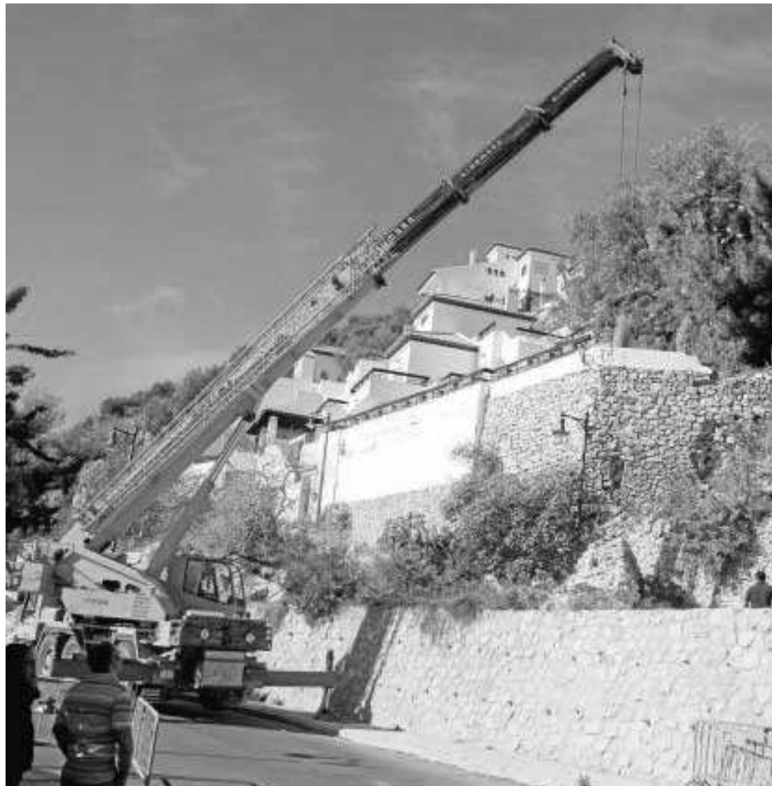
Actuaciones en la urbanización Cármenes del Mar de Cerro Gordo.
