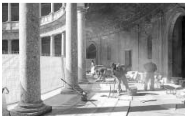
Los trabajos han condicionado las visitas al palacio.
