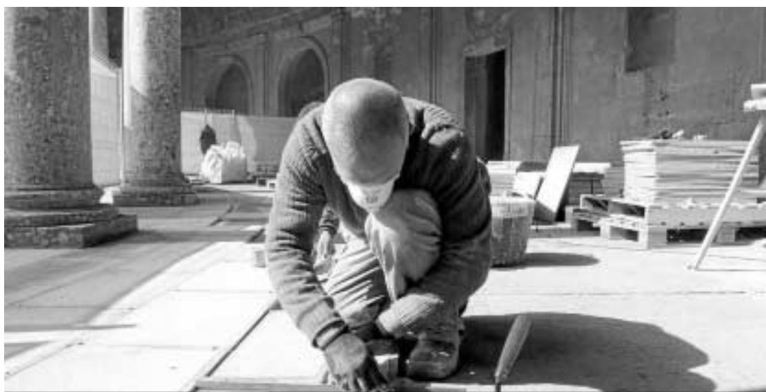
Colocación de las nuevas baldosas por parte de los operarios.
