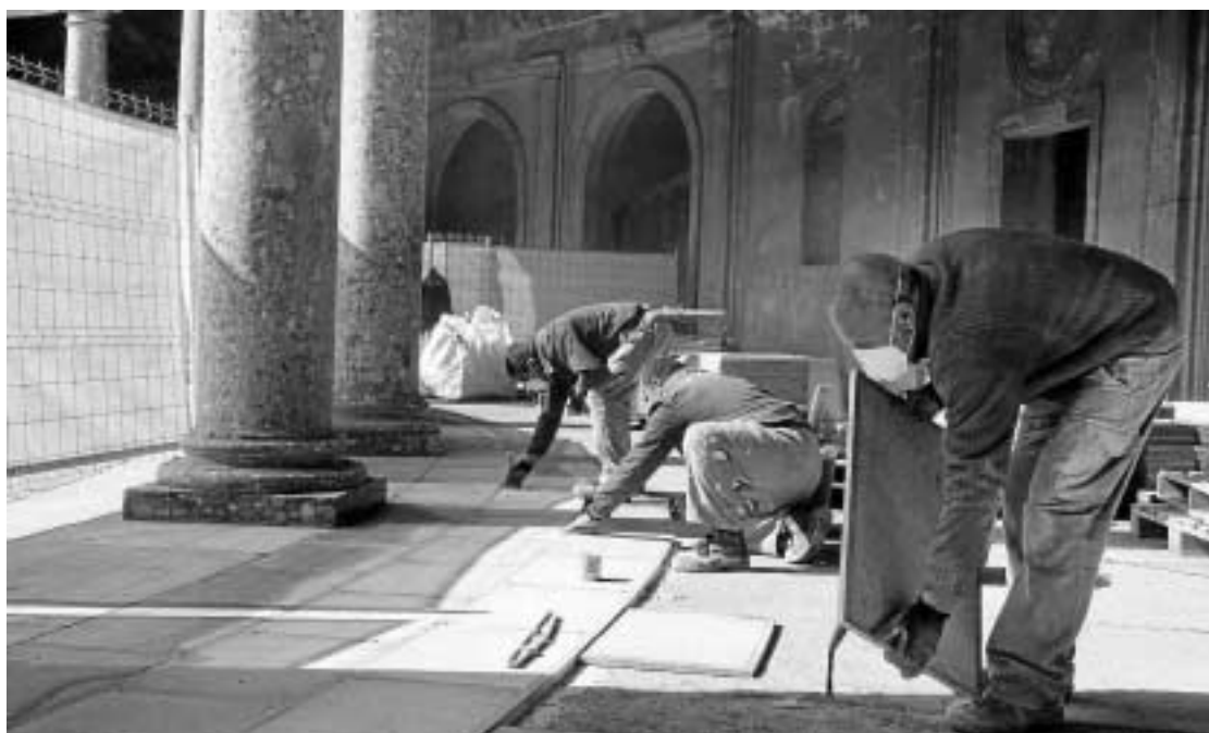
Los encargados de los obras en el Palacio de Carlos V ya han empezado a cambiar el pavimento.
