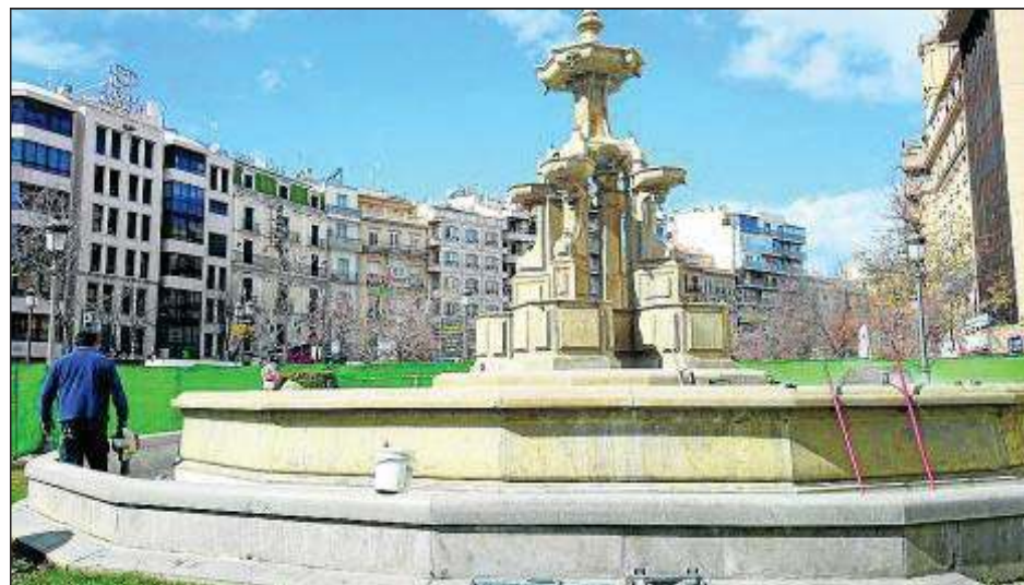
PUESTA A PUNTO EN PUERTA REAL. La Fuente de las Batallas estará vallada y cerrada hasta el viernes. Los operarios del Ayuntamiento trabajan desde ayer en su limpieza. Además, están sellando las juntas de las esquinas para evitar fugas de agua. FOTO: Á. H.
