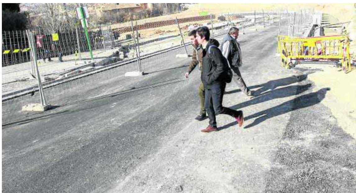
El asfaltado se terminará entre sábados y domingos. :: A. A.
