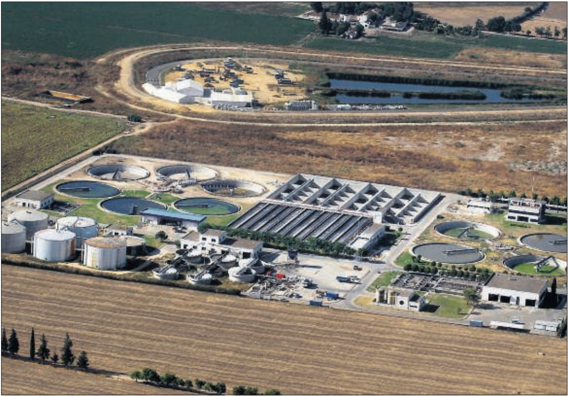
Vista de las instalaciones de la estación depuradora de aguas residuales en Palomares, Sevilla. / P. PUENTES
