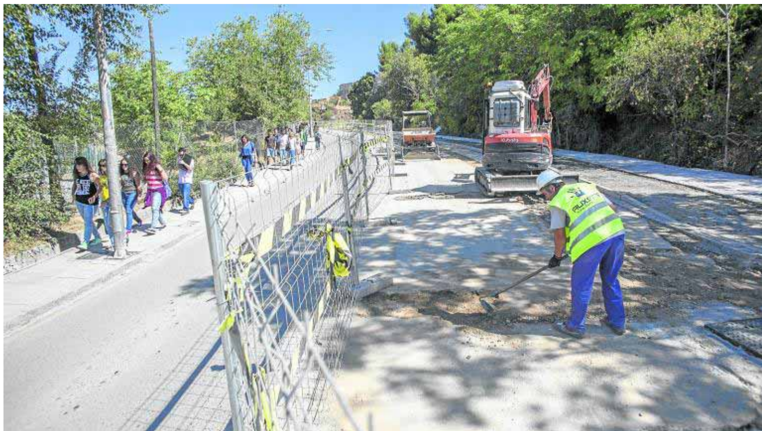
Los universitarios se encontraron en Cartuja con las obras del campus. :: ALFREDO AGUILAR
