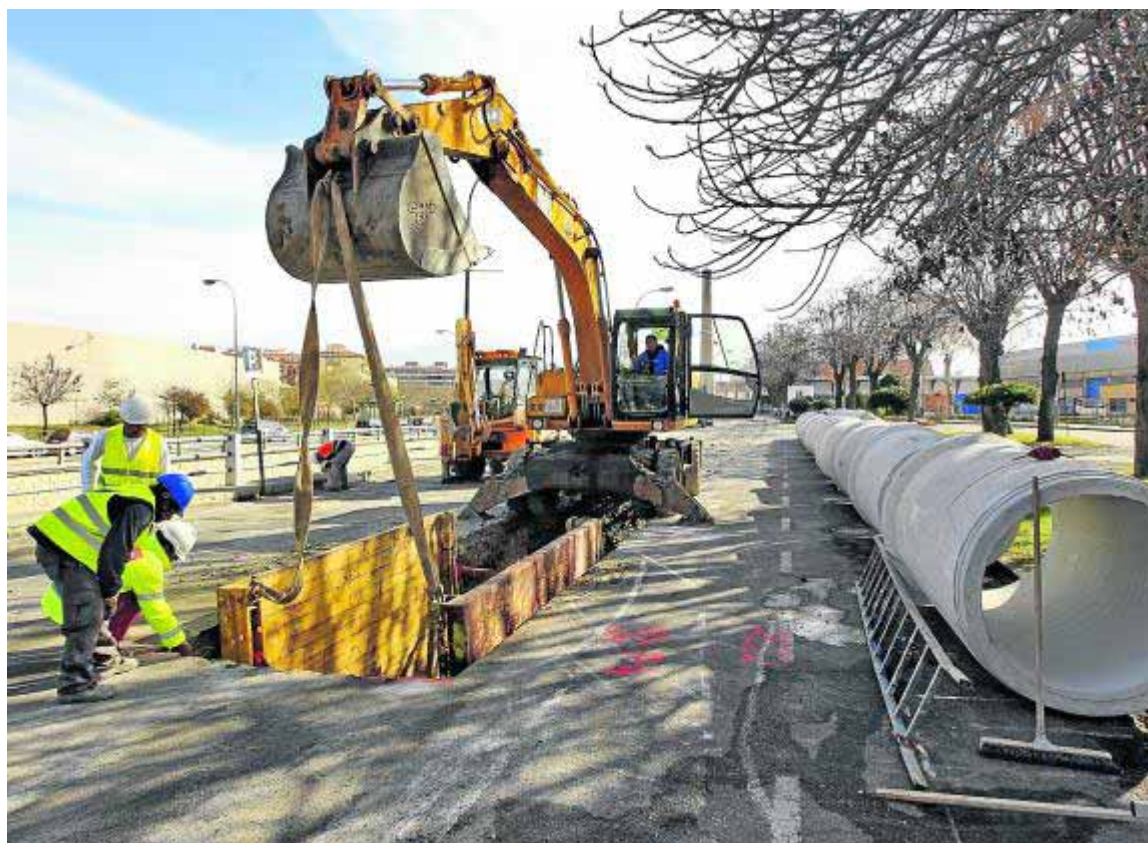
Obras de saneamiento en el PTS para evitar los vertidos. :: RAMÓN L. PÉREZ
