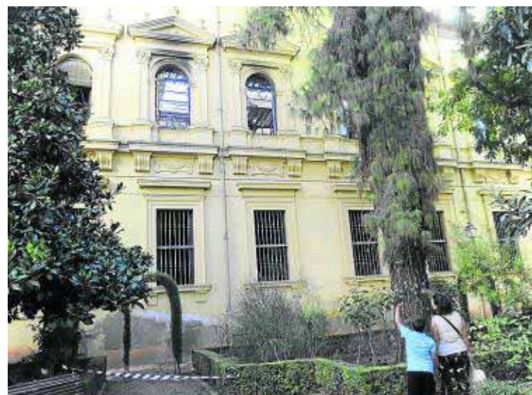
Fachada lateral del edificio teñida de negro por el humo. :: A. AGUILAR
