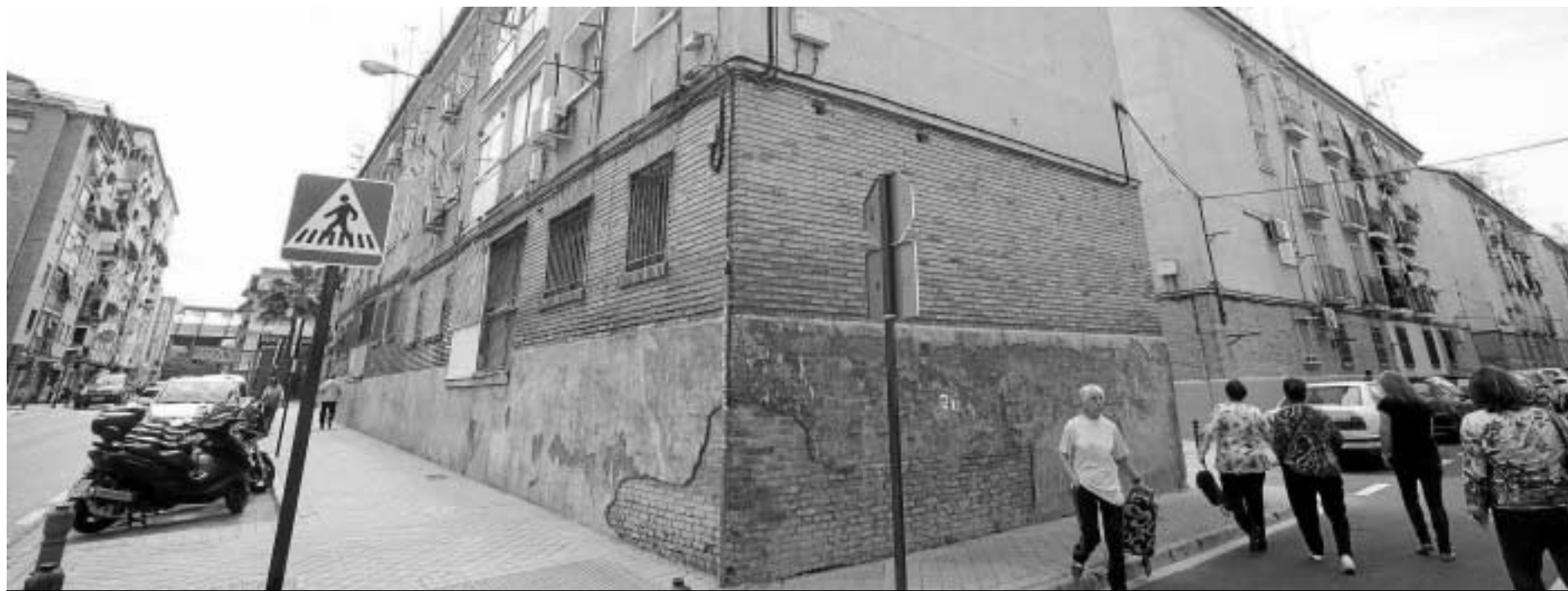
Son numerosas las viviendas que están en muy mal estado; algunas con peligro de derrumbe.
