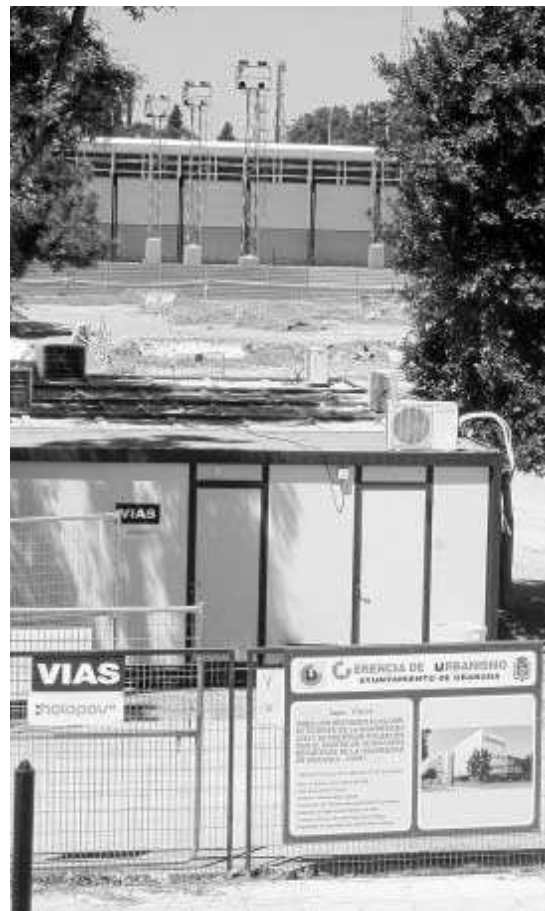
Los obreros trabajan a marchas forzadas en el pabellón de Fuentenueva.
