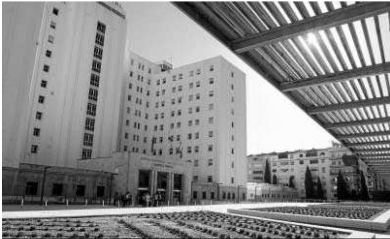
Aspecto que presenta la nueva entrada al hospital.
