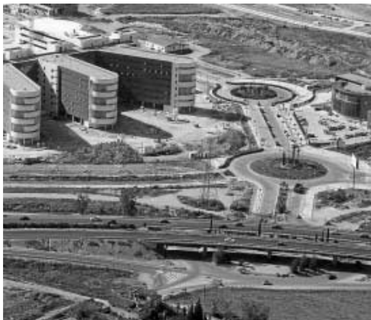
Uno de los accesos que hay que mejorar es la entrada al hospital.
