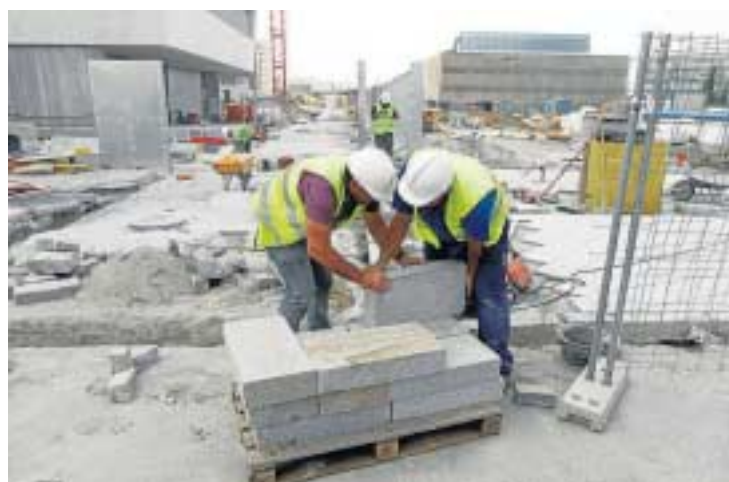
Trabajos en el futuro campus universitario del PTS, el pasado mes de abril.
