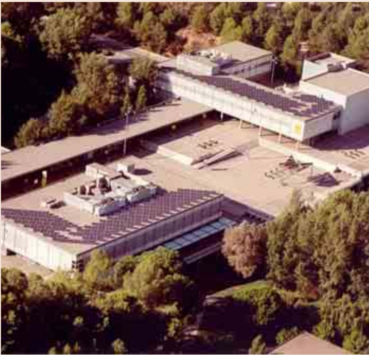
Vista de la instalación fotovoltaica de la Universidad Autónoma de Barcelona.
