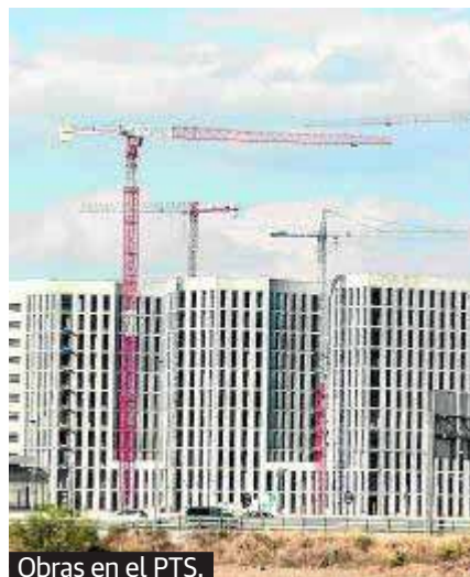
Obras en el PTS.
