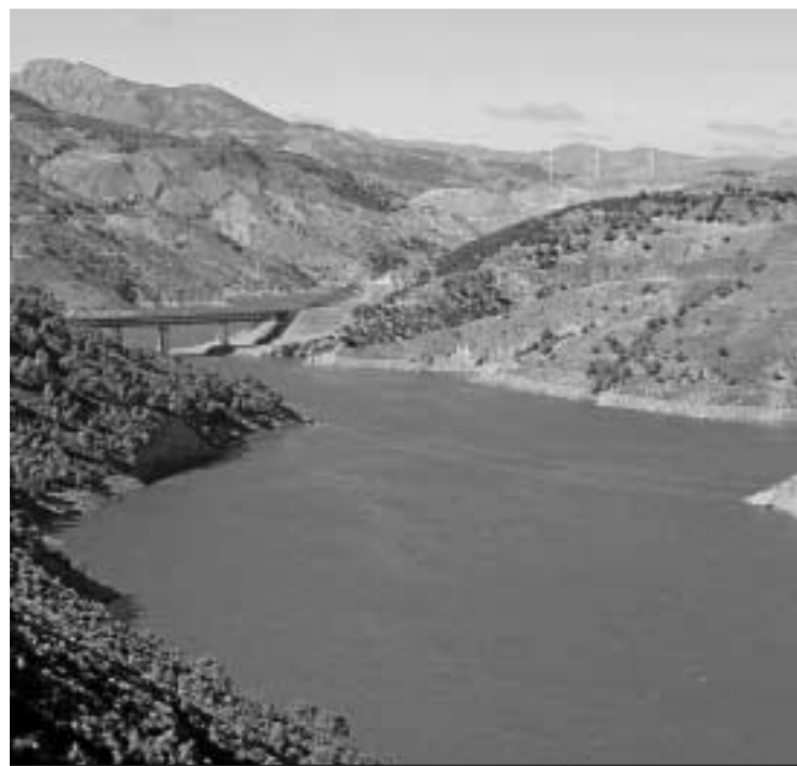
Vista general del agua acumulada.
