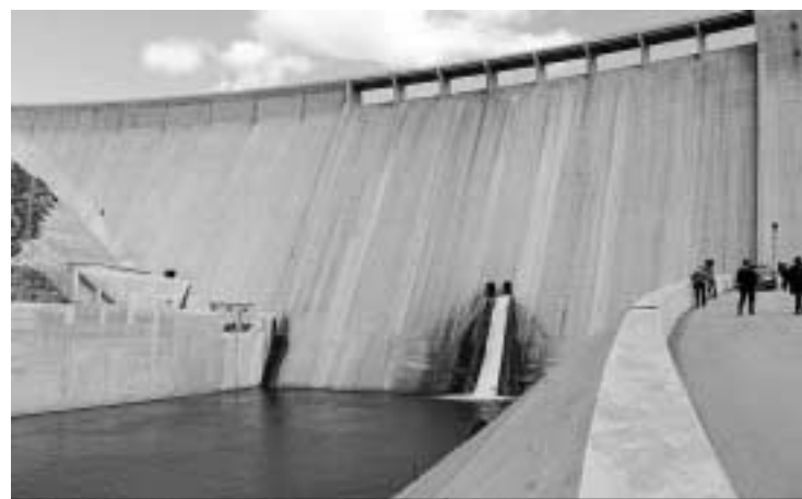
La presa desagua y no tiene aún las canalizaciones.
