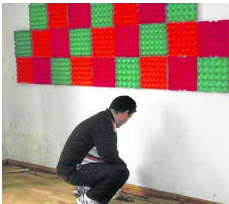
Cartones de huevos para aislar las paredes del gimnasio. ■ I. S.
