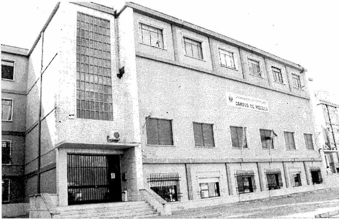
La construcción de nuevas aulas en el Campus servirá para cubrir las necesidades de espacio.
