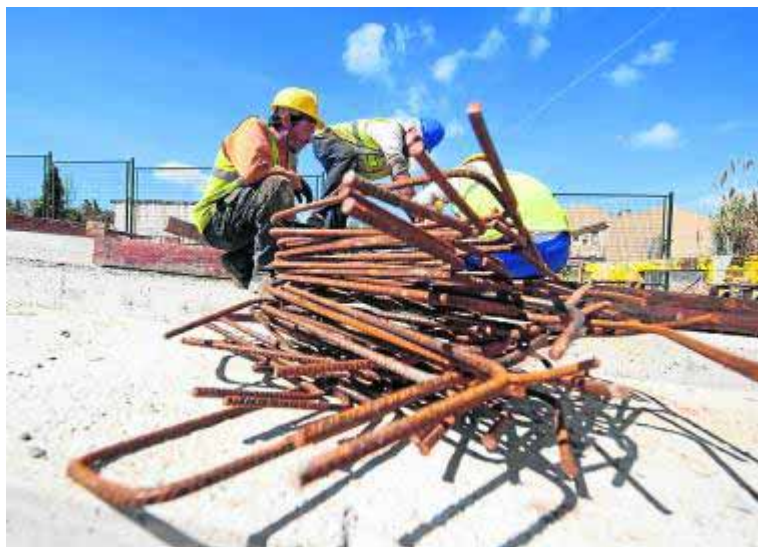
Obras. Trabajadores del metro. ■ R. L. PÉREZ
