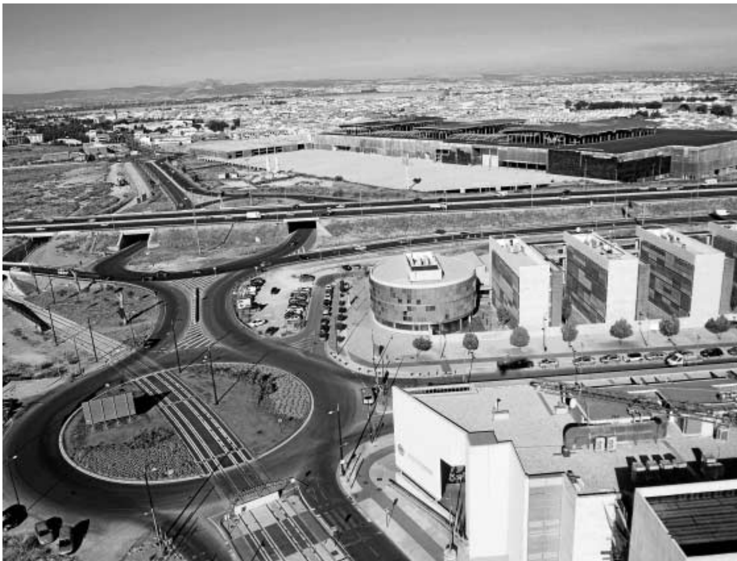
Imagen de algunos edificios del PTS con la zona al fondo de Armilla y Ogíjares, hacia donde crecerá el Parque.
