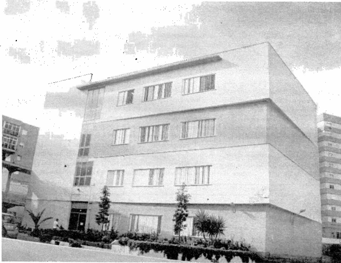
El nuevo aulario ampliará sus instalaciones para acoger más carreras
