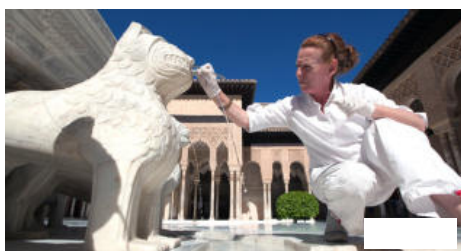
Un momento de la rehabilitación de los leones de la Alhambra. La Opinión
