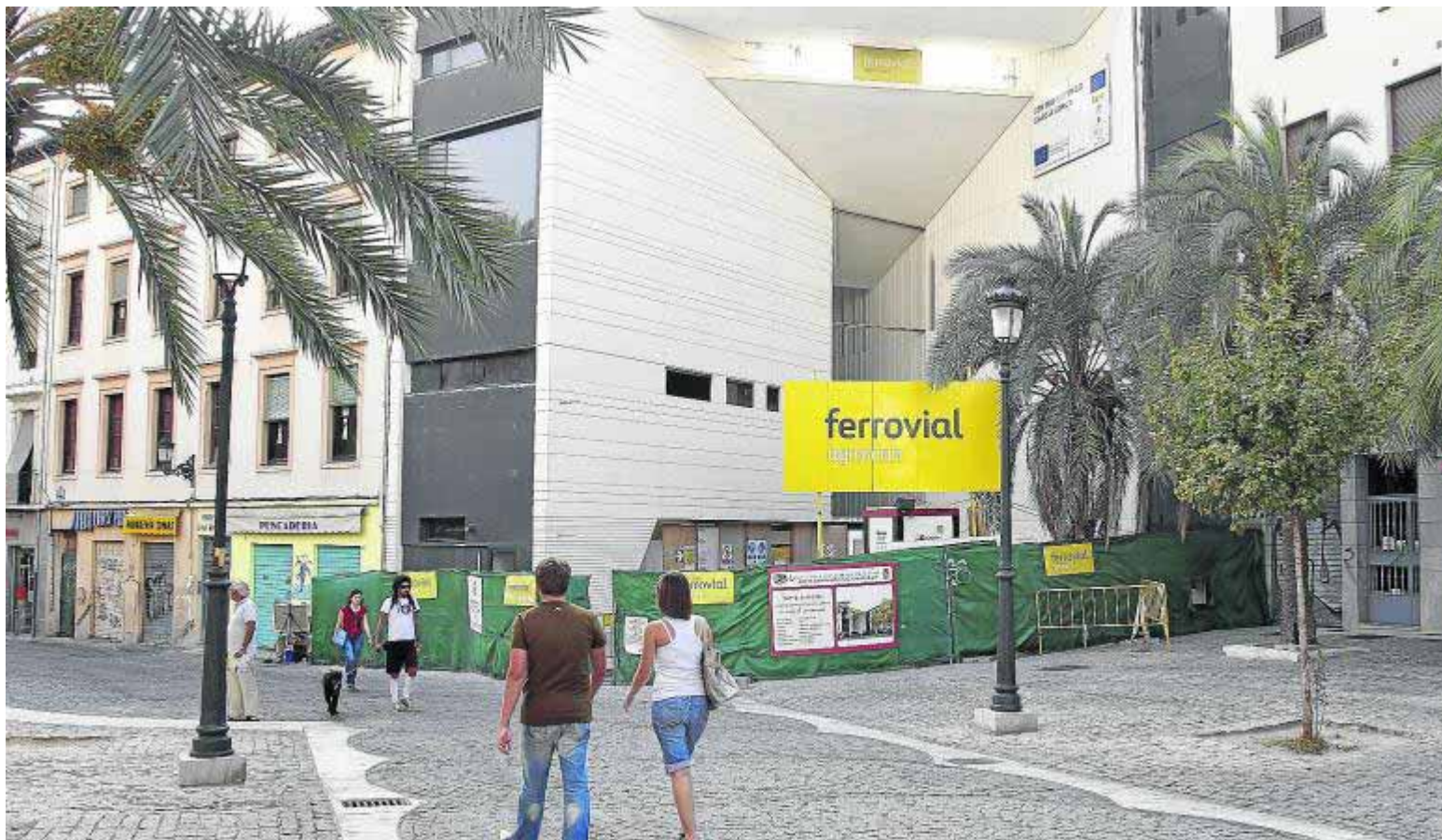
Inmueble del Centro Lorca, en la Plaza de la Romanilla, al que le queda el remate final de las obras. ■ ALFREDO AGUILAR
