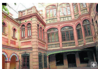
La Escuela Internacional de Posgrado, ubicada en el Palacio de los Condes de la Jarosa.
