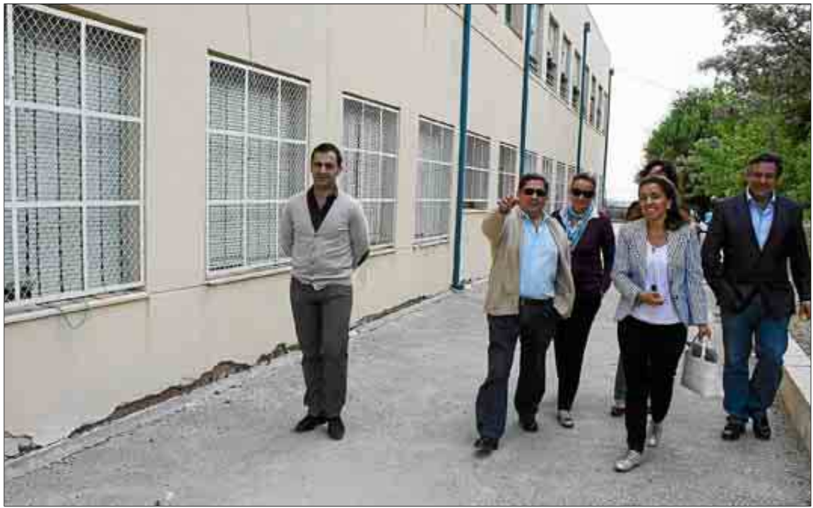
María Jesús Botella visita el colegio de Bujalance, lleno de grietas, como se ve a la izquierda de la imagen. / MADERO CUBERO
