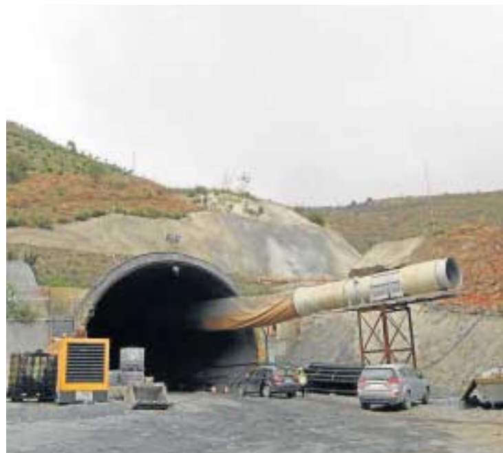
El túnel del tramo entre Taramay y Lobres.
