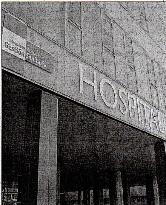
Fachada del Hospital Universitario de Ceuta. / FOTO ARCHIVO
