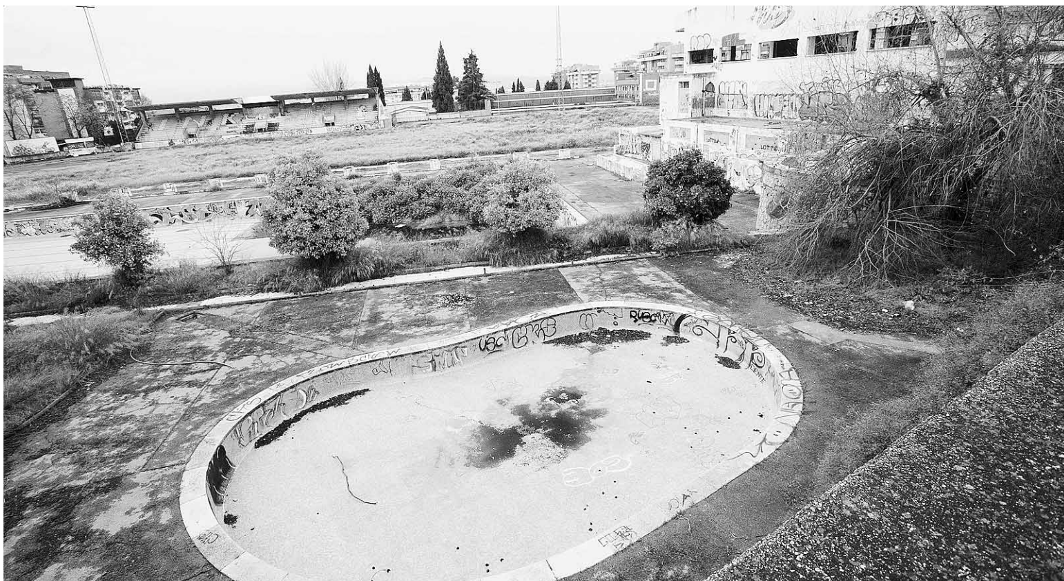
Estado que presentan actualmente las instalaciones del Estadio de la Juventud. :: ALFREDO AGUILAR
