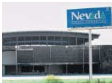
Estado actual del edificio.
