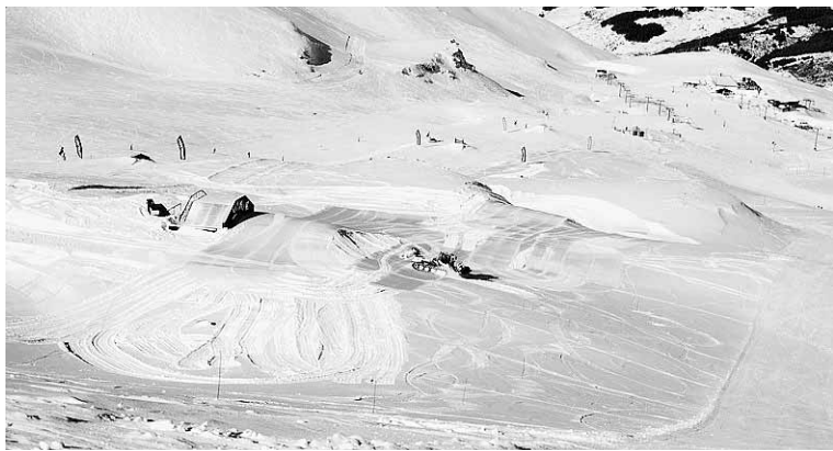
Vista de los trabajos en el snowpark de Loma de Dílar. ■ A. M.
