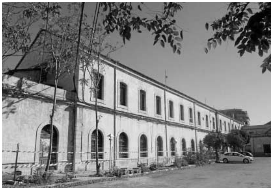
Según el Administrador de Infraestructuras Ferroviarias, el edificio no tiene protección.
