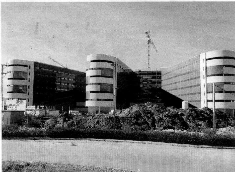
Exterior del nuevo Hospital Clínico que se ubicará en el PTS. MIGUEL ÁNGEL MOLINA
