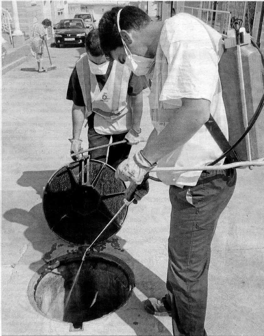
Las alcantarillas son tratadas una a una.
