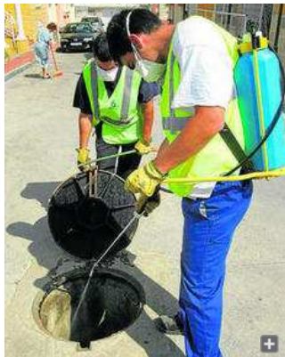
Las alcantarillas son tratadas una a una.
