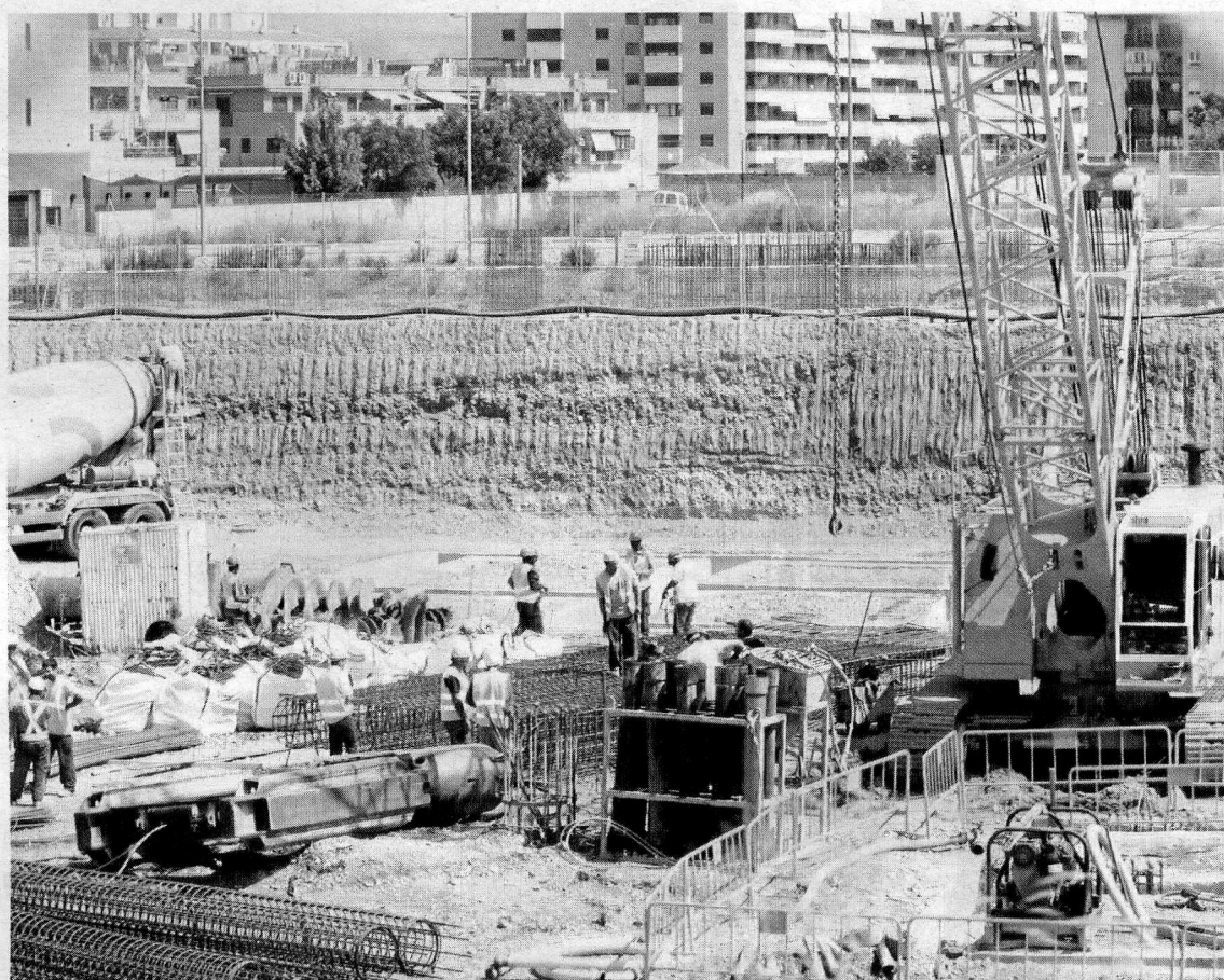
Obras de las facultades de Medicina y Ciencias de la Salud en el Parque Tecnológico Ciencias de la Salud.
