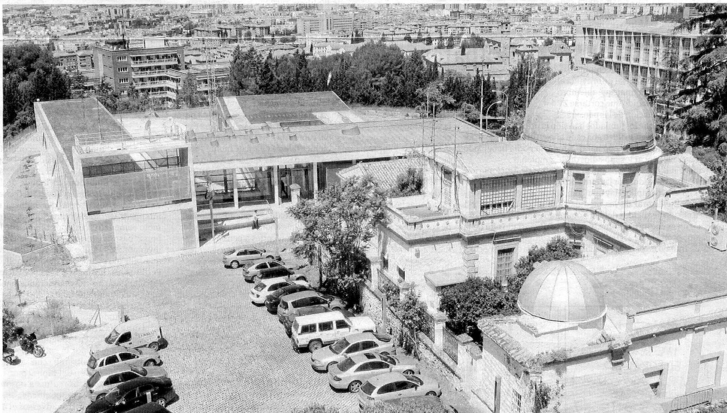
Las nuevas instalaciones del Instituto Andaluz de Geofísica se ubican en la calle Profesor Clavera número 12, junto al 112.
