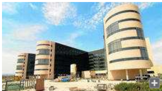
Aspecto que presenta el Hospital del Parque, con el exterior casi acabado ya.
