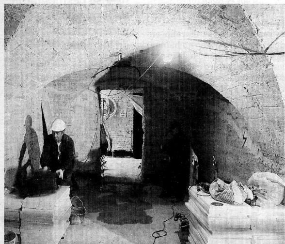
Siguen los trabajos en la bóveda.
