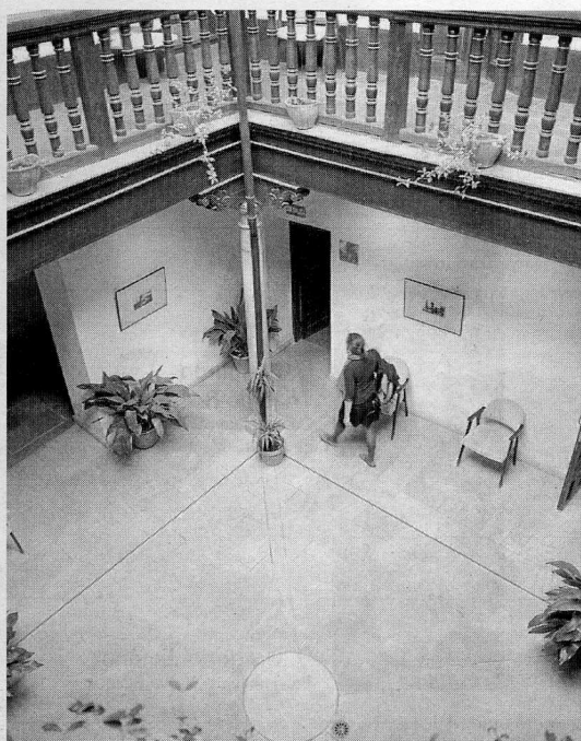
Estado actual del patio, donde ha desaparecido el brocal del pozo.
