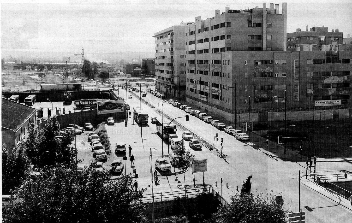
Por aquí llega el encauzamiento hasta conectar con el río Monachil en la avenida de Dílar. / GONZÁLEZ MOLERO
