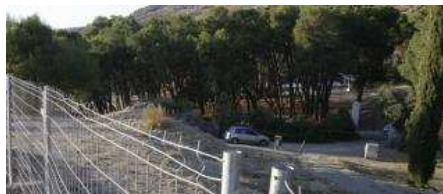
Vista del parque Federico García Lorca, ayer, vallado para iniciar las excavaciones. Juan Palma
