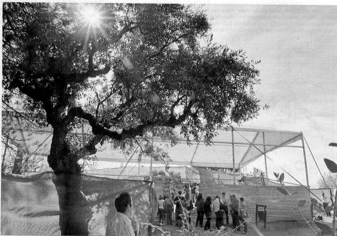
La nave garantizará la privacidad de los trabajos en las fosas y protegerá el terreno de las inclemencias del tiempo.
