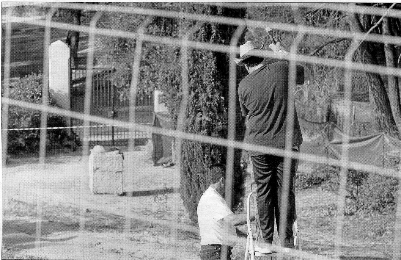
Dos técnicos clavan un poste para colocar la malla protectora, en el paraje Fuente Grande de Alfacar. FOTOS: JUAN PALMA
