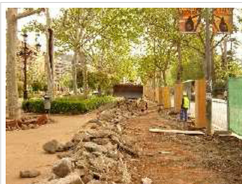
Obras en el Paseo del Salón
