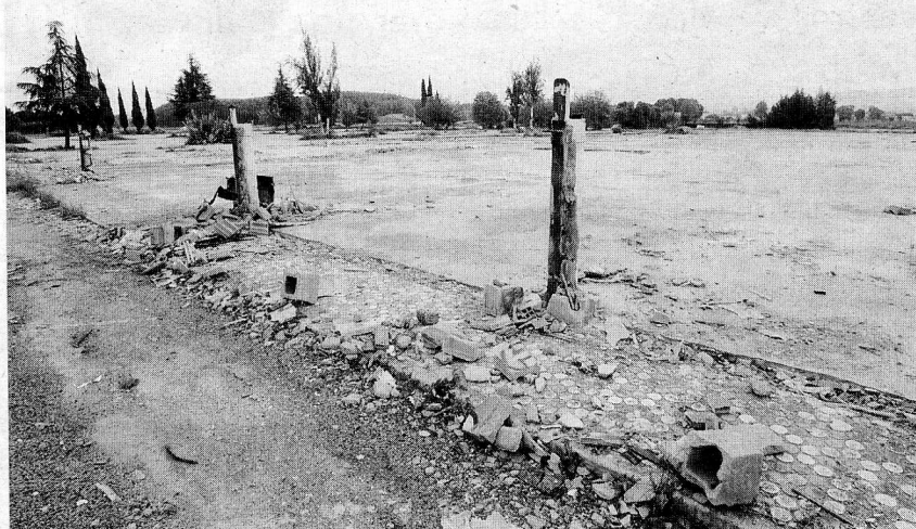
TRAS LA DEMOLICIÓN. El edificio del Híper fue echado abajo en 2006. /J.O.
